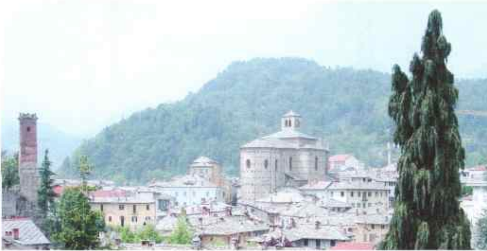
VISTA PANORAMICA DAL TERRAZZO DEL SECONDO PIANO
